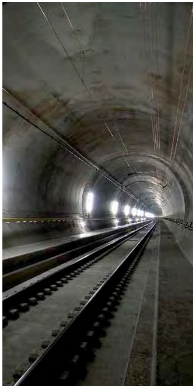
7 Bahntechnik eingebaut, Teststrecke Bodio West 7 Rail technology installed, test section Bodio West
