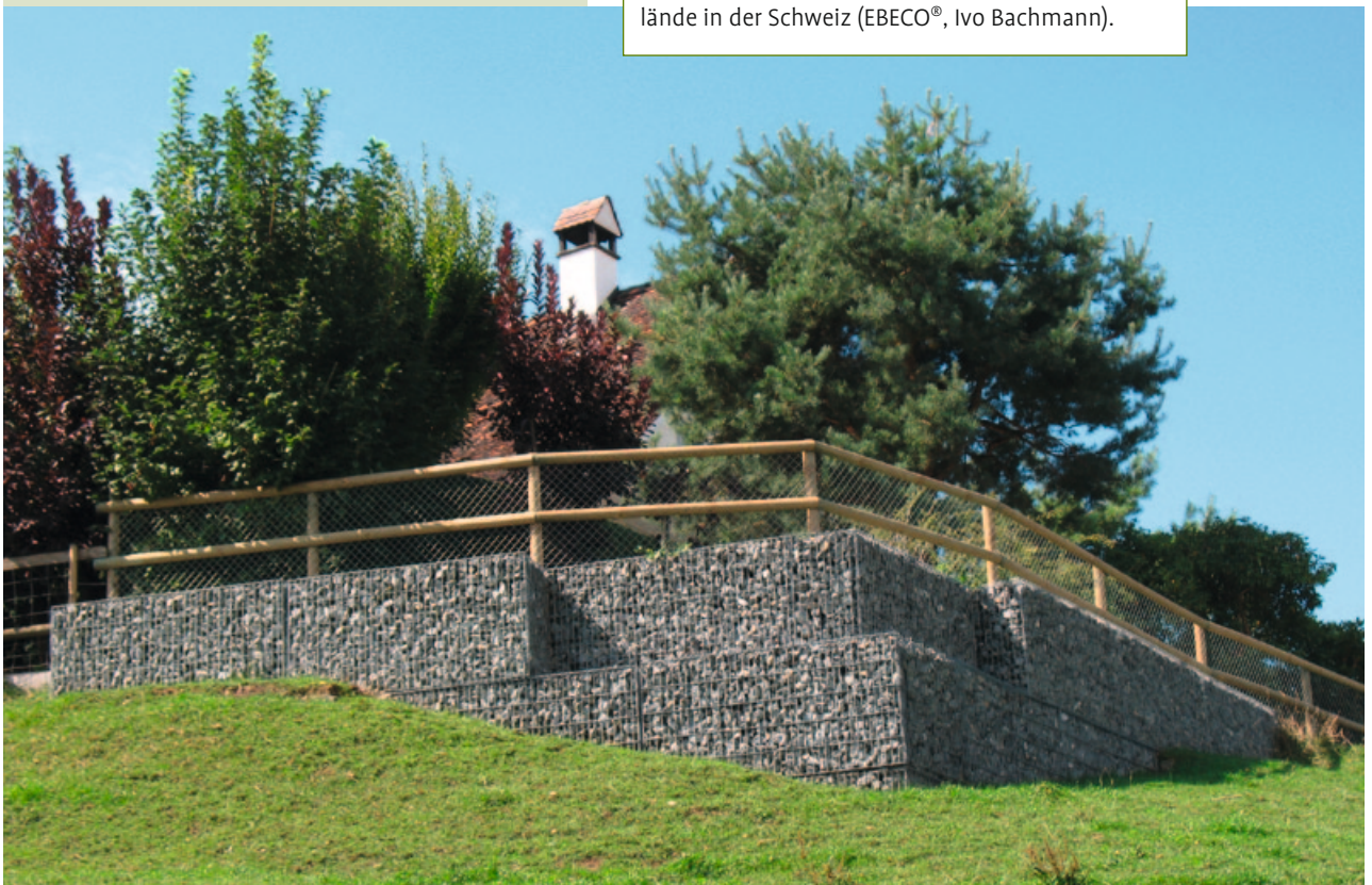
Unten: Ökologische Geländeterrassierung mit gefüllt transportablen Steinkörben in steilem Gelände in der Schweiz (EBECO®, Ivo Bachmann).
