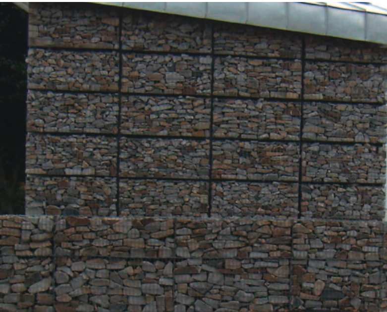
Wandverkleidung mit hängefähigen Gabionen der Breite 15,5 cm, eingehängt in vertikalen Lochschienen mit Lastabtragung über Fundament in Remscheid (EBECO®).
