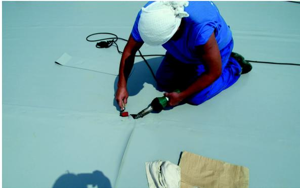
Wegen des großen Dachgefälles konnte kein Schweißautomat zur thermischen Verschweißung eingesetzt werden. Arbeiten mit Heißluftföhn brachten keine zufriedenstellenden Ergebnisse hinsichtlich der Schälfestigkeit.
