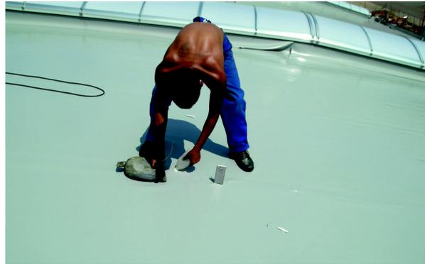
Auf Empfehlung des Herstellers (Lehrverleger) wurden Nähte im Quellschweißverfahren geschlossen. Es wurde vielfach keine homogene Verbindung der Nähte erreicht. Morgendliches Tauwasser verhinderte zeitweise das Erreichen eines ausreichenden Scherwiderstands.
