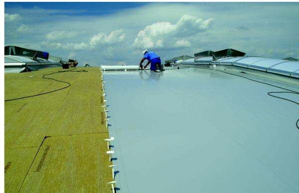
Das Tonnendach erforderte schon bei der Arbeitsausführung Schutzmaßnahmen gegen Abrutschen und Absturz mittels Sicherungssystemen als Einzelanschlag (Gebäudehöhe: 21 m)
